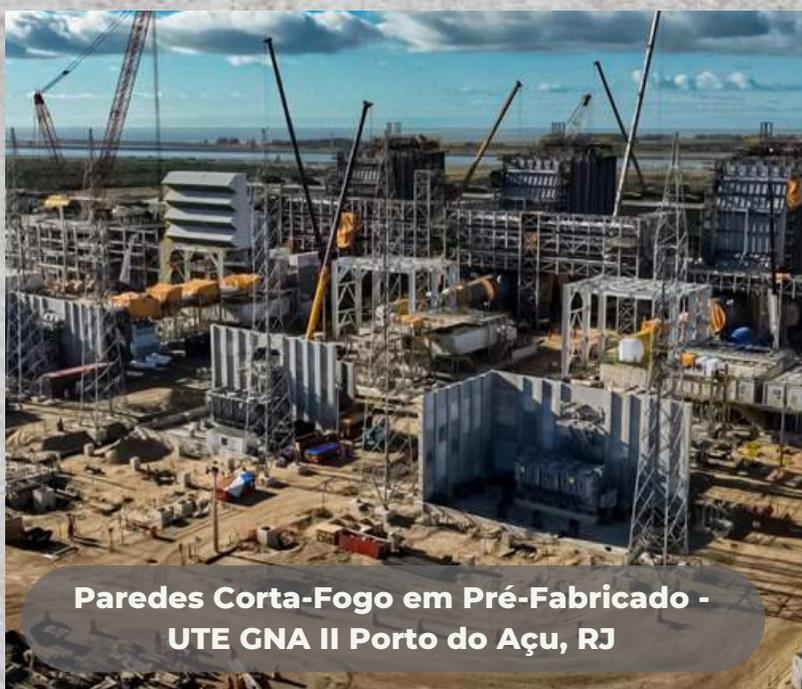
**Paredes Corta-Fogo em Pré-Fabricado -
