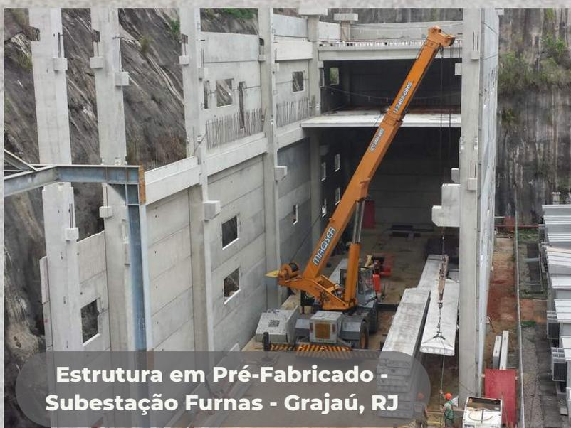
**Estrutura em Pré-Fabricado -
